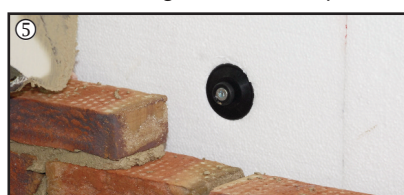
Gevelsteen ongehindert plaatsen.
