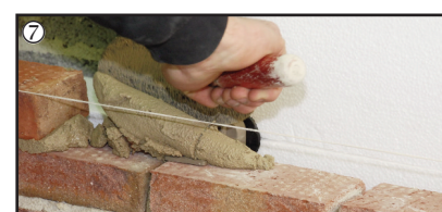
Parement-haak in mortel inbedden.
