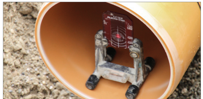
Afb. 5-12 Controle afschot (helling) met een laser
