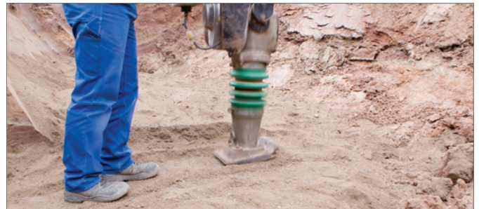
Afb. 5-25 Ondergrond van de schachtbodem voorbereiden
