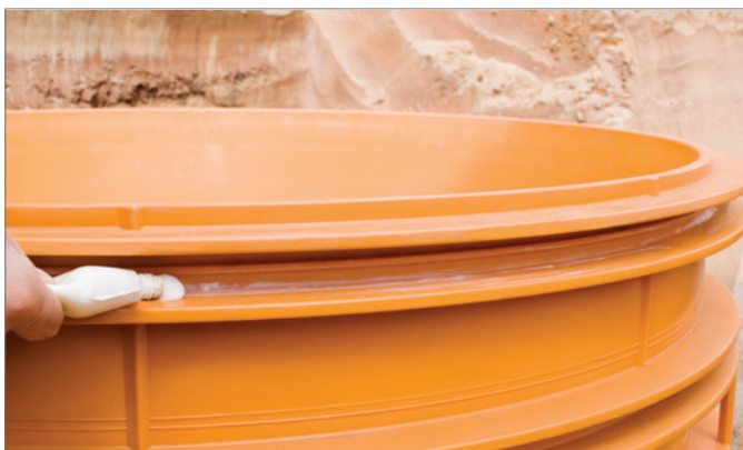
Afb. 5-26 Bovenste afdichtkamer met glijmiddel insmeren
