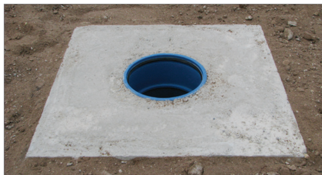
Afb. 5-2 Betonnen sokkel met dubbele insteekmof
