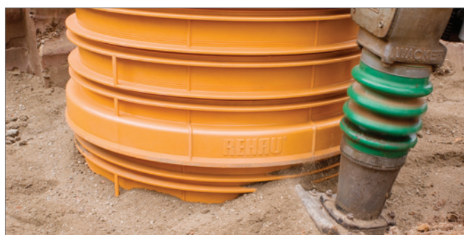
Afb. 5-31 Vullen en verdichten van de schachtomgeving
