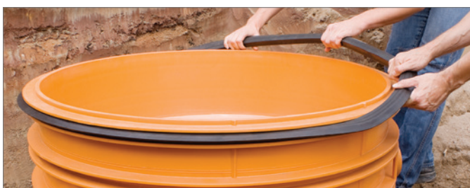
Afb. 5-27 Opspannen van de schachtelementafdichting
