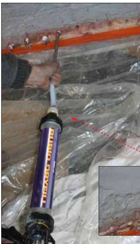
klassieke manier van werken werken met Rubio® Dryfill injectiegel
