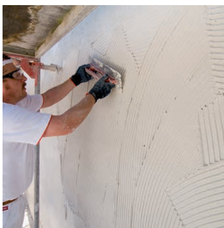
Toepassing van Baumit multiContact MC 55 W
