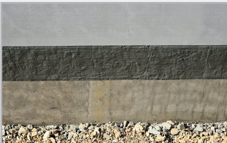
Afgedichte opslagvoeg
