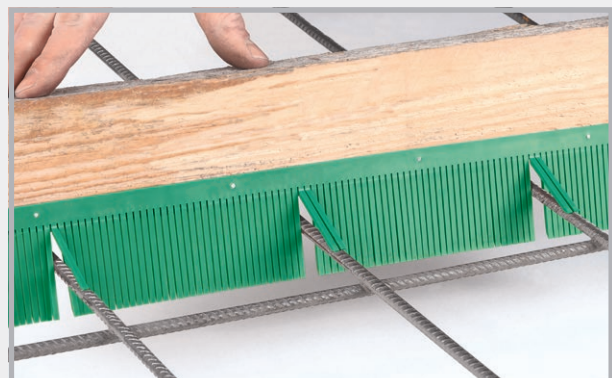
Kanthout in juiste positie plaatsen, uitlijnen en met achterverankering vastzetten
