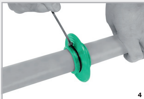
Stevig handmatig aantrekken van de spanbanden
