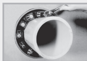
Achtereenvolgens elke schroef een slag vastdraaien en dit in een kring zolang herhalen tot alle modules gelijkmatig vast zitten
