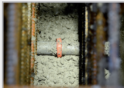
De bekistingsafstandshouder met ActiveRing wordt ingebetonneerd.
