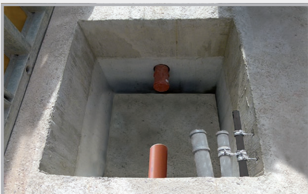
Na het betonneren: lichtgrijs herkent men de pompput, donkergrijs de gebetonneerde vloer.
