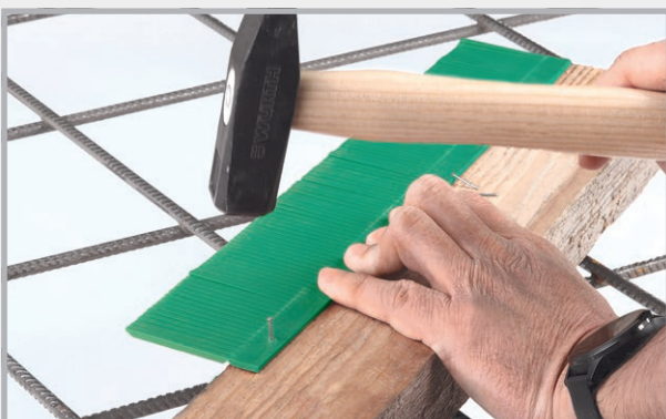
Stortonderbrekingskam op kanthout vastzetten
