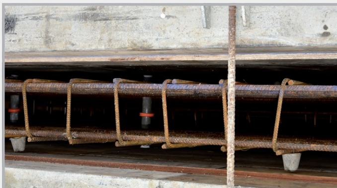
Wandbekisting van bovenaf
