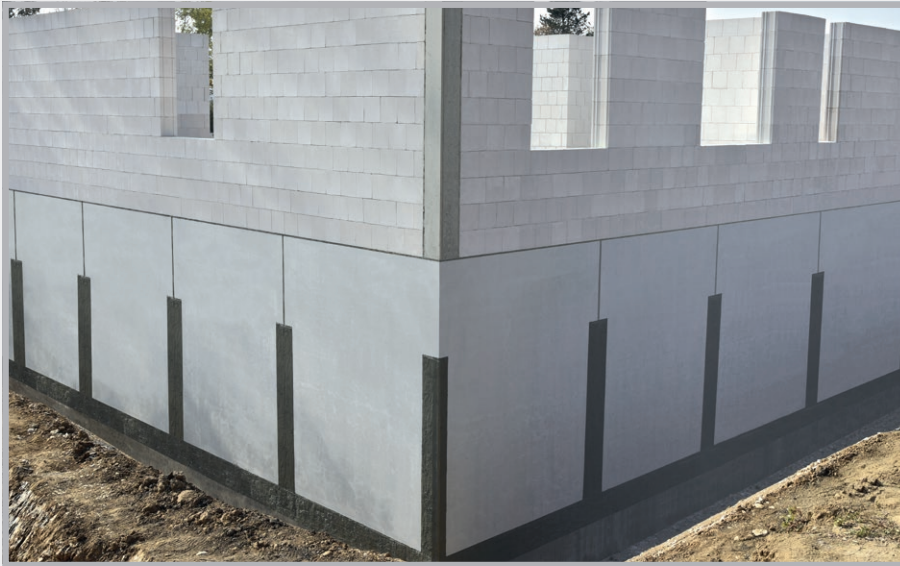
Afgedichte opslag- en naadvoegen
