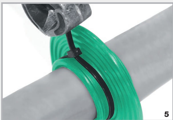
De spanbanden kunnen ook met een tang worden aangetrokken
