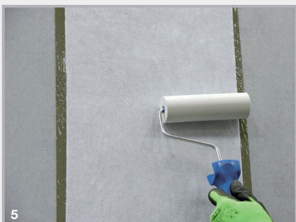
5 Gebruik de aandrukrol om het vlies over het volledige oppervlak in de coating te rollen. Met deze handeling kan de tweede laag, afhankelijk van de temperatuur en vochtigheid, na ongeveer 2 tot 3 uur worden aangebracht.
