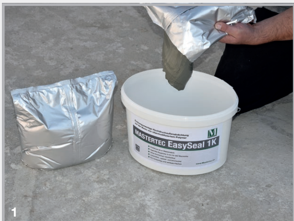
1 Open de zakken en doe de coating in de emmer.
