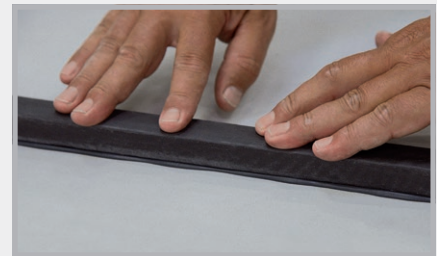
De zwelband in het lijmbed drukken
