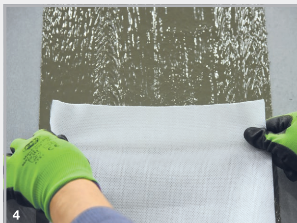
4 Lijn het vlies uit en druk het zachtjes aan.
